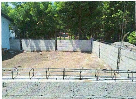
Foto1: Area para aula tipo portico 1
