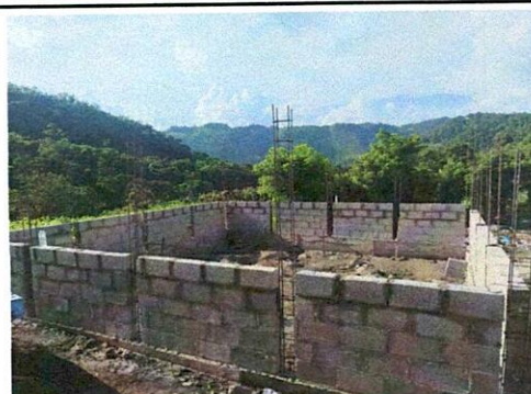
Foto 4: Area para aula 2 tipo portico
